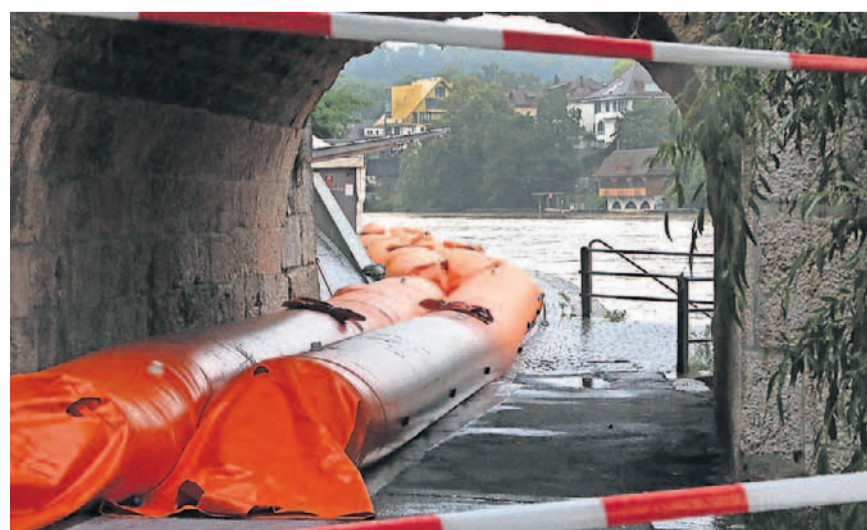
Bleiben vorläufig stationiert: Hochwassersperren der Feuerwehr Olten. HR, AESCHBACHER
